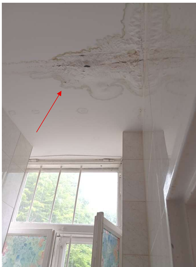
fot.9. widoczne zacieki i zawilgocenia na suficie w łazience
