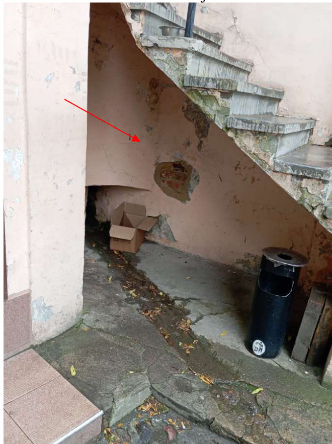
fot.35. widoczne ubytki tynku, zawilgocenia ściany oraz zły stan techniczny schodów zewnętrznych prowadzących na taras przy werandzie
