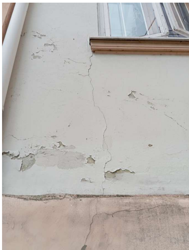
fot.53. widoczne zarysowania tynku na elewacji południowej
