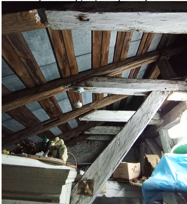
fot.57. widoczna konstrukcja dachu: krokwie podparte belkami wspartymi na zastrzałach i ściankach stolcowych
