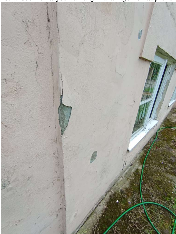
fot.41. widoczne zarysowania, ubytki i odspojenia tynku na elewacji północnej
