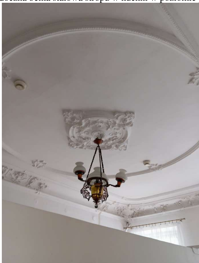
fot.14. widoczne zdobienia i rozety gipsowe na suficie
