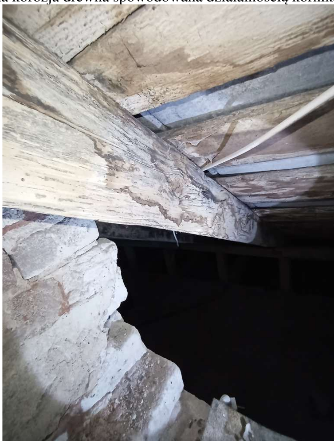
fot.67. widoczna korozja biologiczna, zacieki i zawilgocenia na krokwi i deskowaniu
