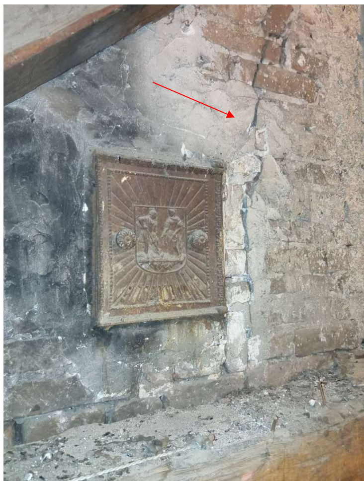
fot.24. widoczny pęknięcie ściany szczytowej poddasza
