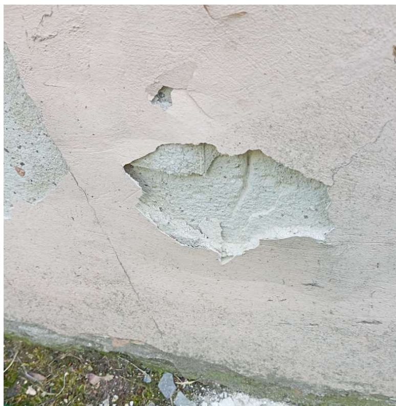
fot.44. widoczne zarysowania, ubytki i odspojenia tynku na elewacji zachodniej
