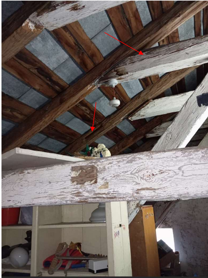
fot.56. widoczna konstrukcja dachu z pęknięciami podłużnymi elementów drewnianych
