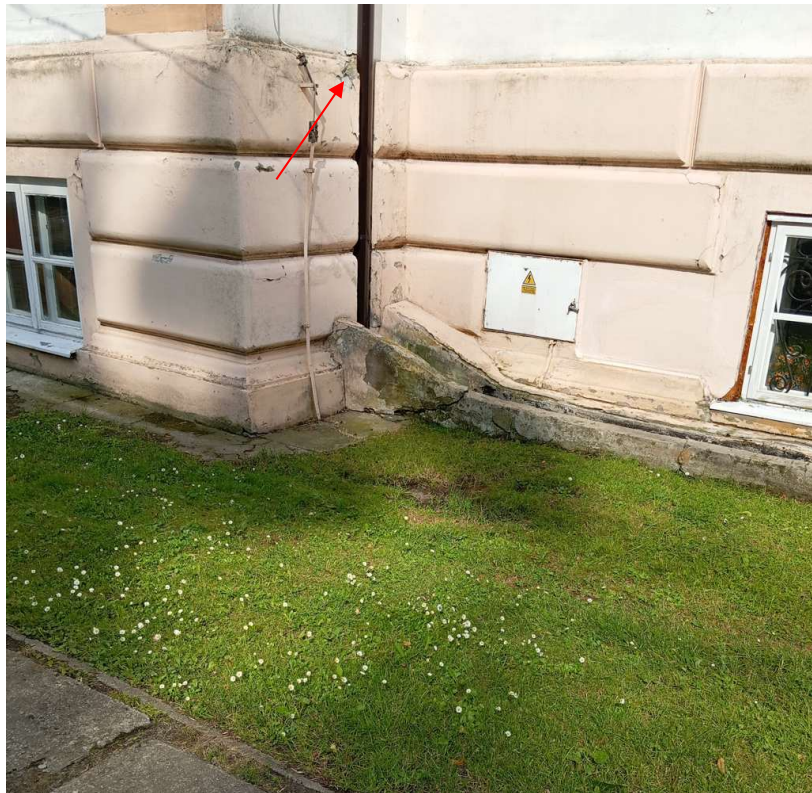
fot.48. widoczne zarysowania, ubytki tynku i zawilgocenia w rejonie rury spustowej na elewacji zachodniej
