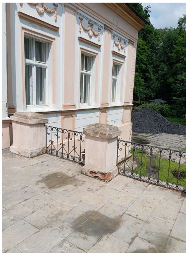
fot.29. widoczne ubytki tynku i cegły na słupie tarasu od elewacji wschodniej
