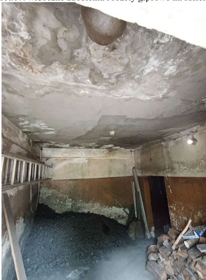
fot.18. widoczne zawilgocenia i zagrzybienia stropu w pomieszczeniu kotłowni
