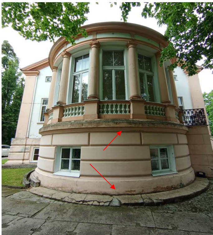
fot.54. widoczne zawilgocenia i odparzenia tynku na elewacji południowej
