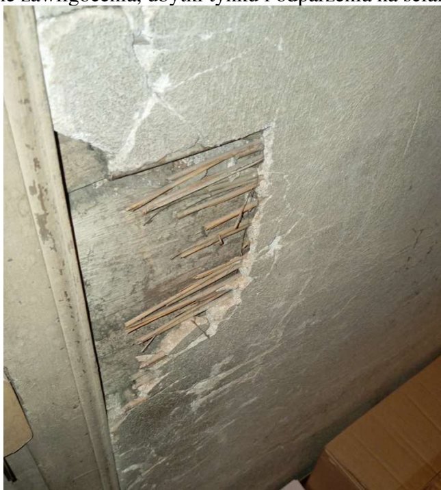
fot.23. widoczny tynk na trzcinie na ścianie wewnętrznej poddasza
