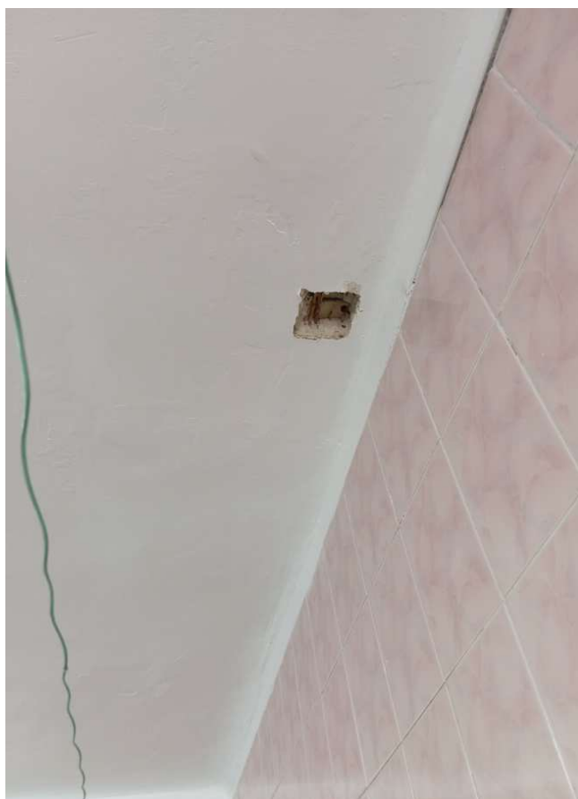
fot.7. widoczna okrywka stropu od spodu nad pomieszczeniem pralni - widoczny tynk na trzcinie i podbitka drewniana
