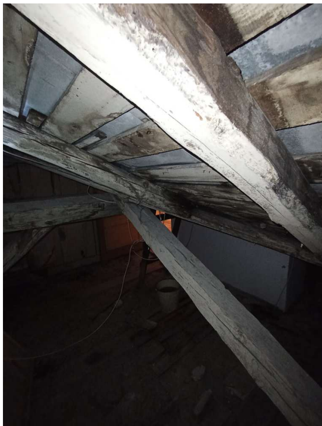
fot.70. widoczne zawilgocenie i zagrzybienie krokwi
