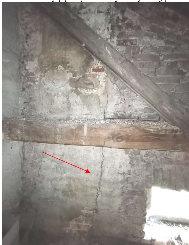
fot.25. widoczny pęknięcie ściany szczytowej poddasza
