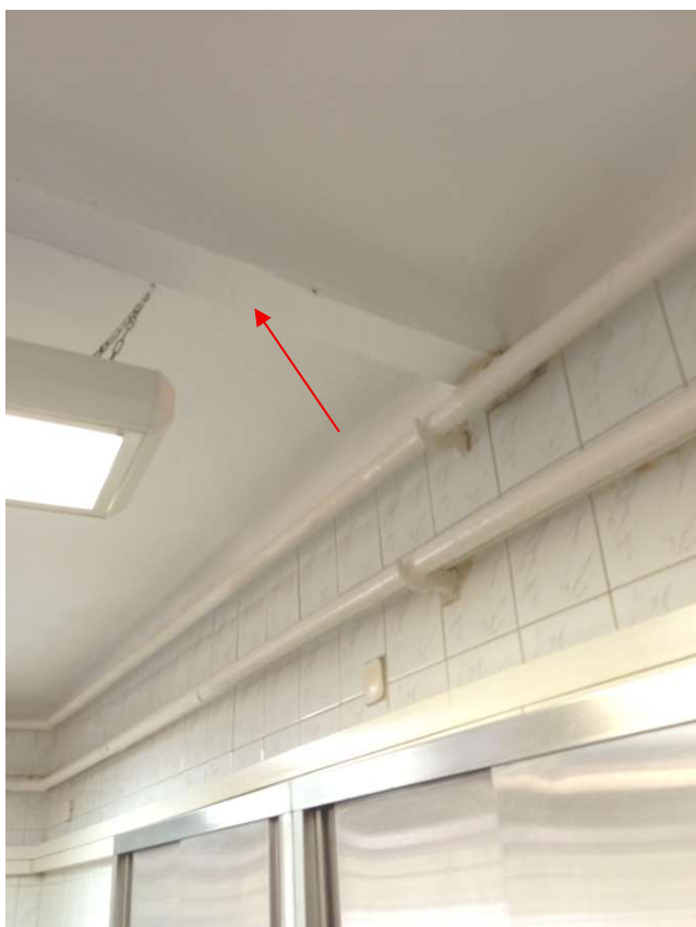
fot.13. widoczna belka stalowa stropu w kuchni w poziomie przyziemia
