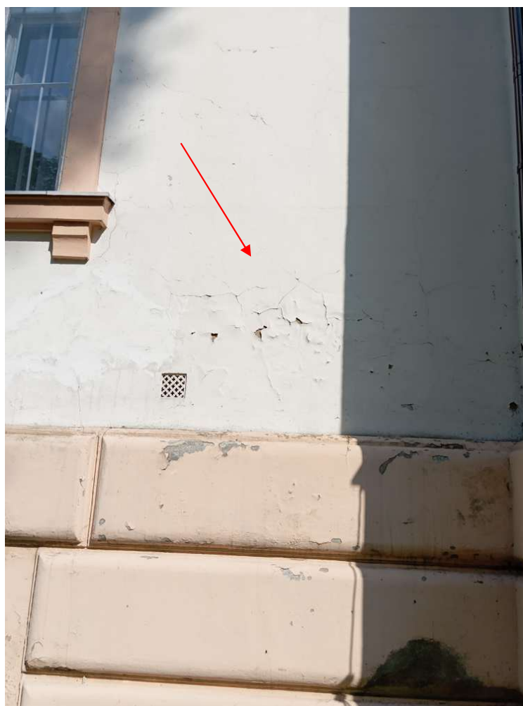
fot.47. widoczne zarysowania na tynku na elewacji zachodniej
