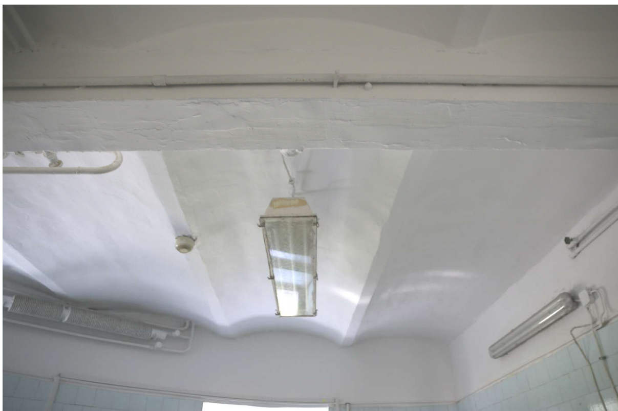
fot.5. widoczne belki stalowe i sklepienia ceglane w pomieszczeniu zmywalni w poziomie przyziemia
