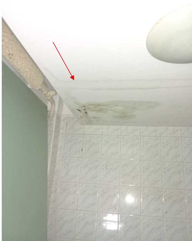
fot.10. widoczne zacieki i zawilgocenia na suficie w łazience
