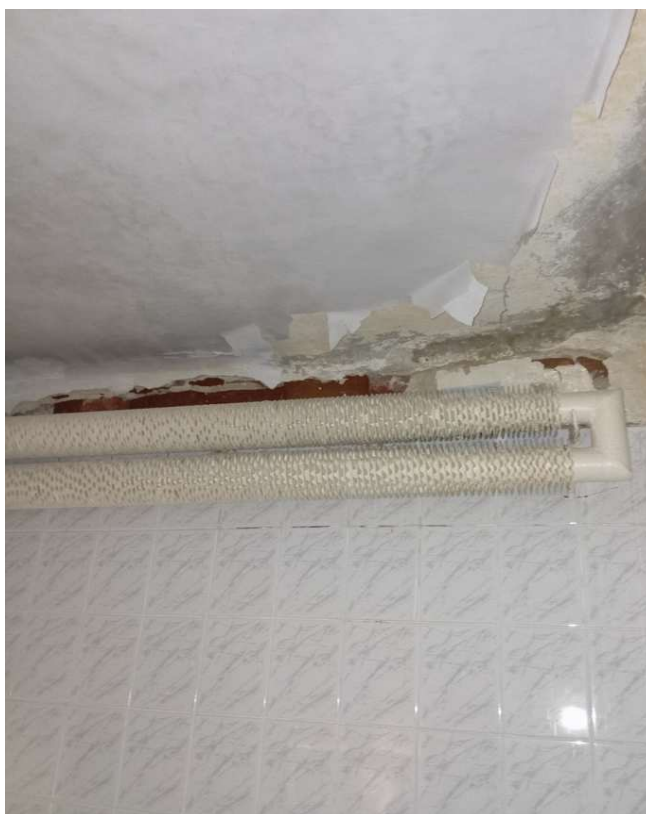
fot.11. widoczne zacieki, zawilgocenia odparzenia tynku i farby na suficie w pralni
