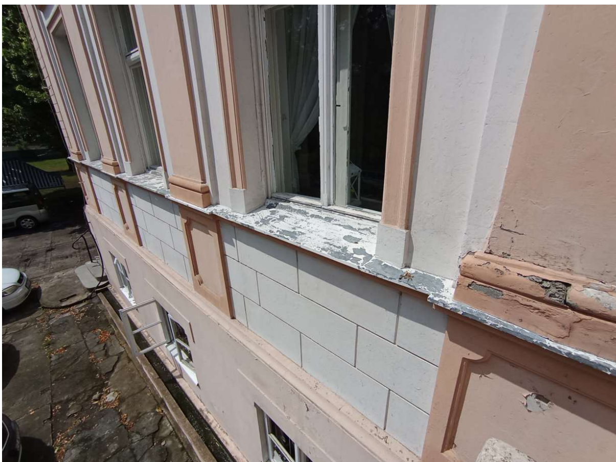
fot.30. widoczne zarysowania, ubytki tynku i odparzenia na elewacji wschodniej
