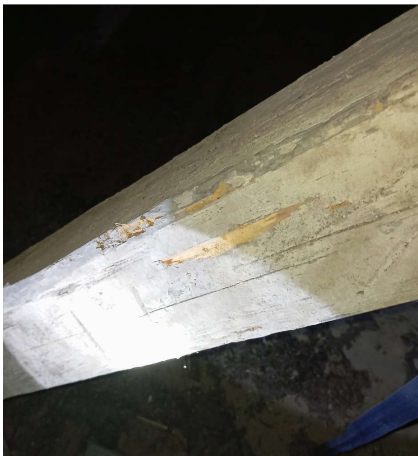
fot.66. widoczna korozja drewna spowodowana działalnością kornika i próchnieniem
