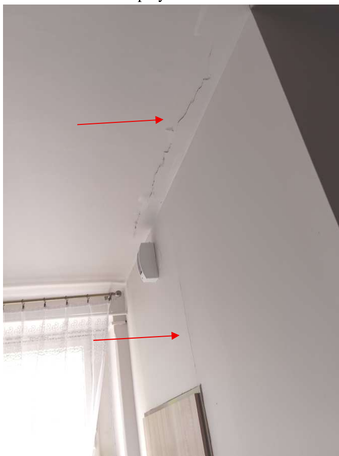
fot.6. widoczne zarysowanie stropu przy styku ze ścianą działową łazienki
