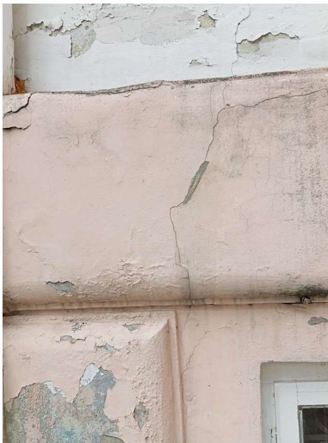
fot.52. widoczne zarysowania tynku na elewacji południowej
