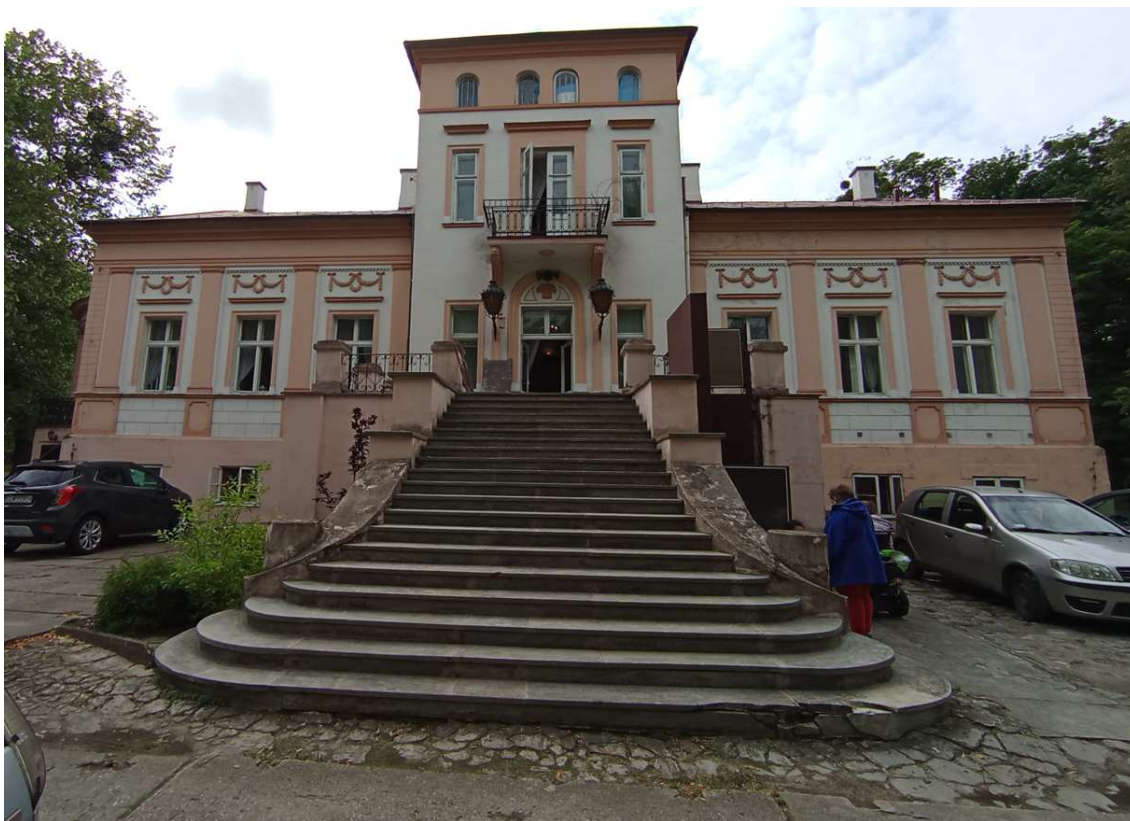
fot.28. widoczna elewacja wschodnia oraz ubytki okładziny na schodach zewnętrznych
