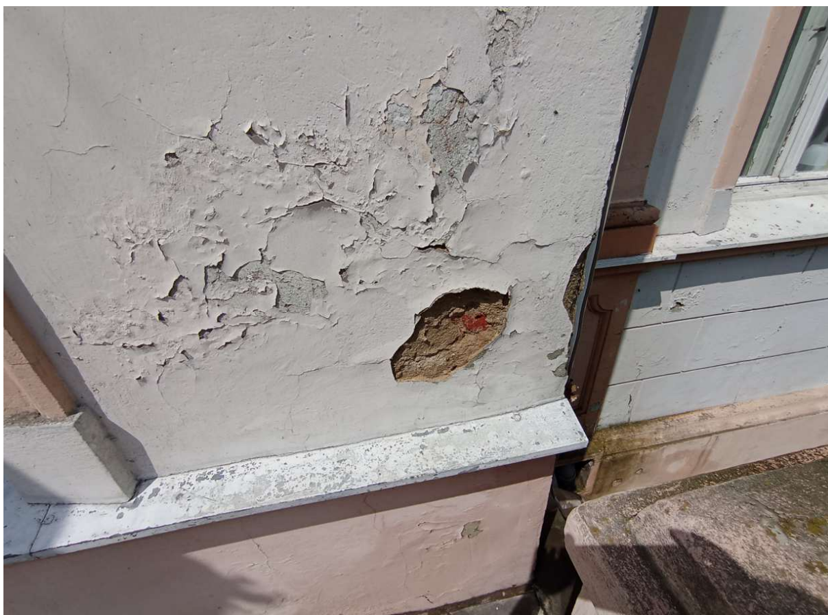
fot.32. widoczne zarysowania, ubytki tynku i odparzenia na elewacji wschodniej
