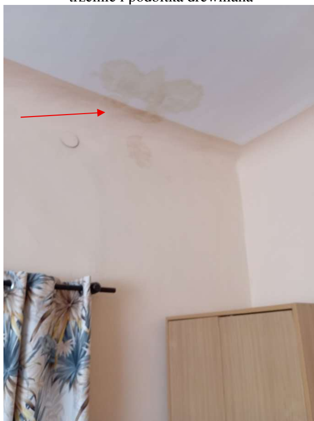
fot.8. widoczne zacieki i zawilgocenia na suficie i ścianie w pokoju
