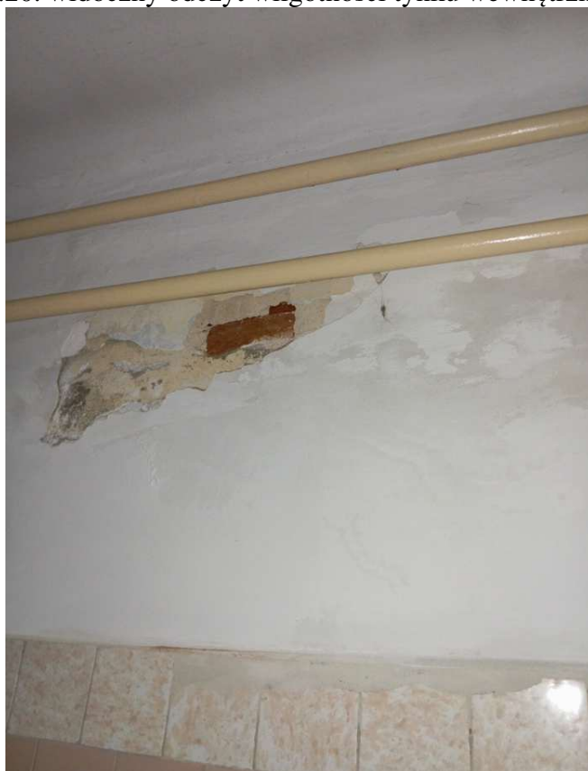
fot.21. widoczne zawilgocenia, ubytki tynku i odparzenia na ścianie wewnętrznej
