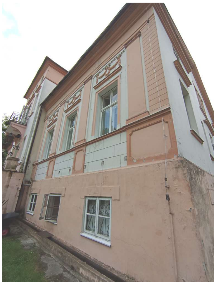
fot.38. widoczne zagrzybienia tynku na elewacji w narożniku ściany wschodniej i północnej
