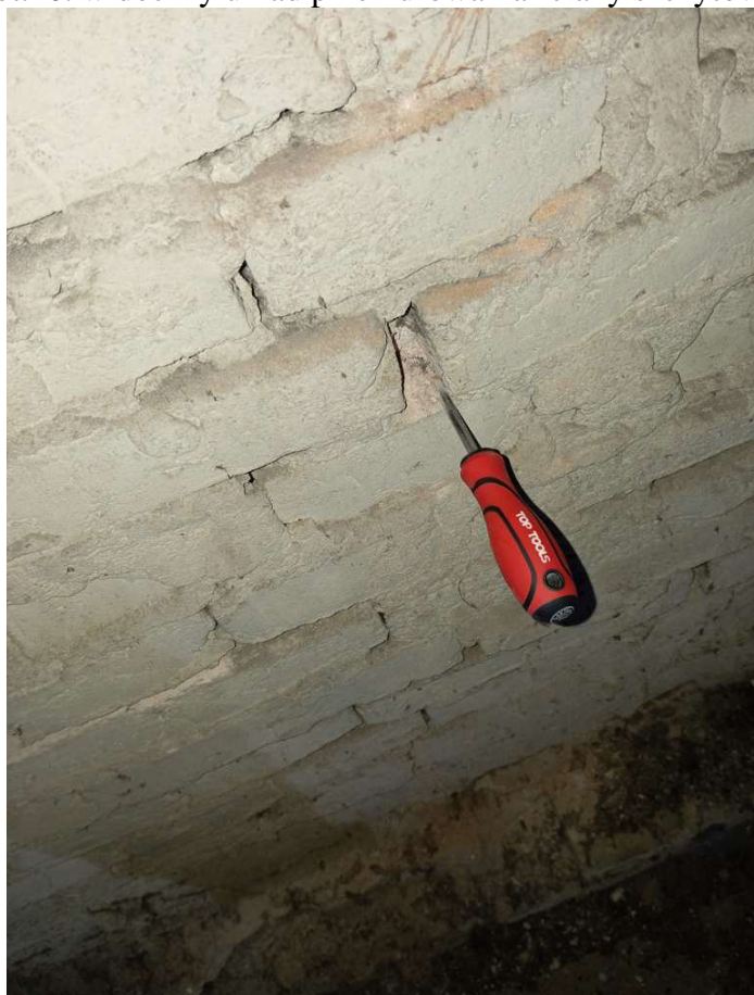
fot.27. widoczny stan zaprawy między cegłami i zagłębienie ostrza ze stali hartowanej na 1,5cm w zaprawie, świadczące o niskiej klasie zaprawy
