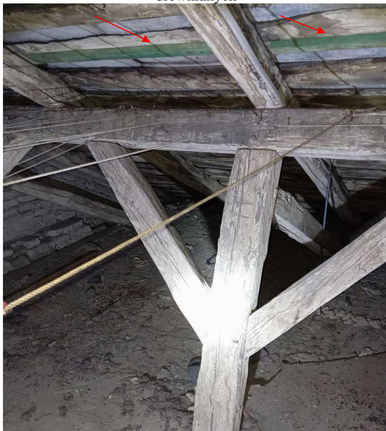
fot.65. widoczny układ konstrukcyjny dachu, korozja biologiczna elementów drewnianych oraz wtórnie dołożone łąty drewniane
