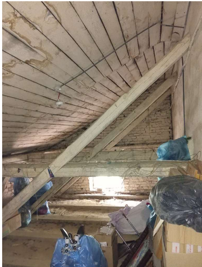
fot.58. widoczna konstrukcja dachu niższego: krokwie podparte belkami poziomymi i skośnymi zastrzałami, widoczne zacieki na deskowaniu dachu
