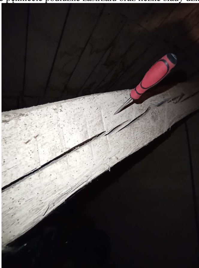
fot.61. widoczne pęknięcie podłużne zastrzału oraz liczne ślady działalności kornika
