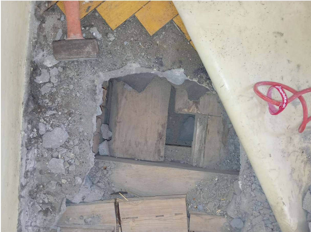
fot.1. odkrywka 01-widoczna belka drewniana, deski ślepego pułapu, warstwa posadzki betonowej, parkiet i wykładzina PCV
