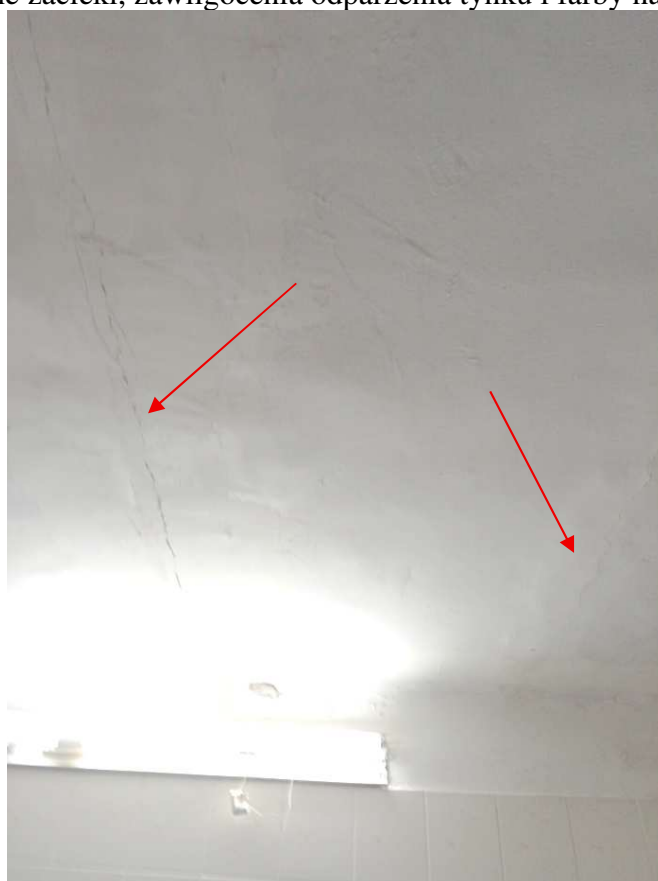
fot.12. widoczne wyrysowania na tynku na suficie w linii belek stropowych
