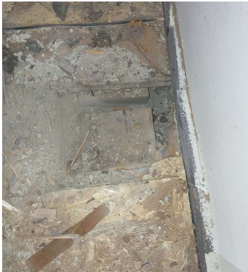
fot.2. odkrywka 02-widoczna belka drewniana, gruz, legary drewniane i płyta osb
