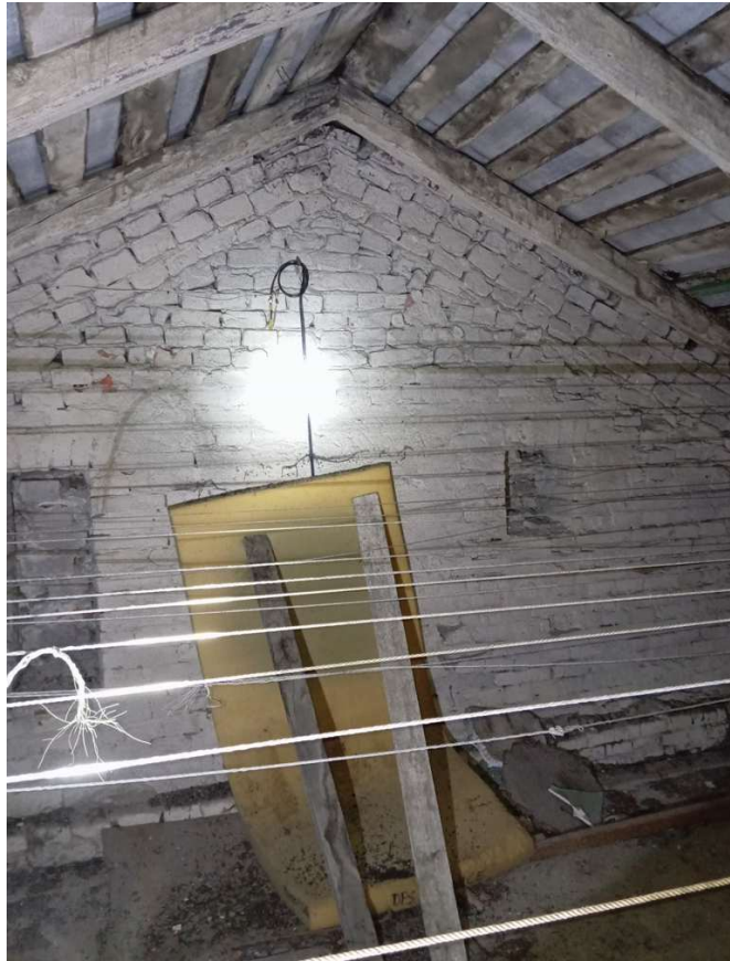
fot.26. widoczny układ przemurowania ściany szczytowej
