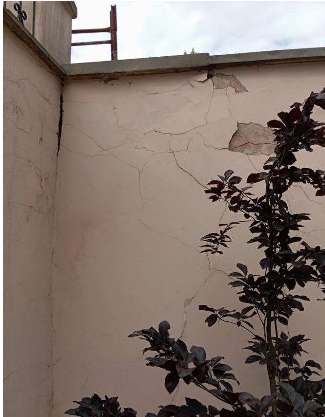
fot.34. widoczne zarysowania i ubytki tynku na ścianie przy schodach zewnętrznych elewacji wschodniej
