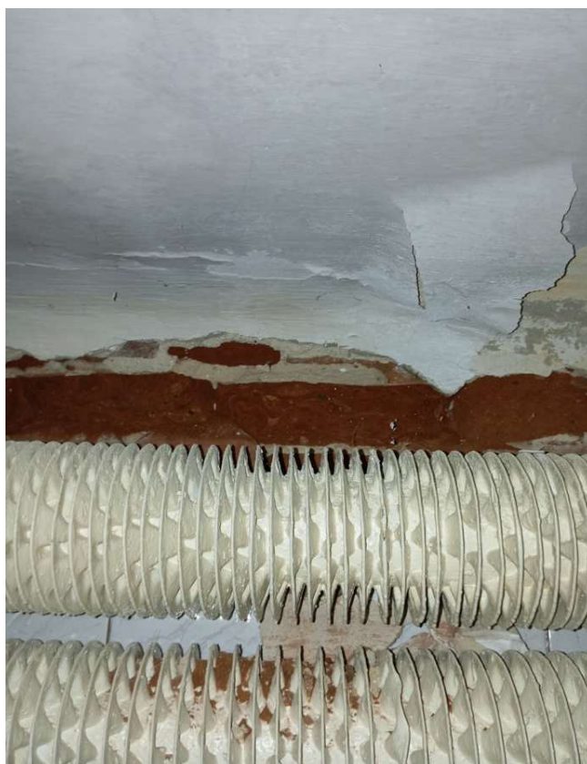
fot.22. widoczne zawilgocenia, ubytki tynku i odparzenia na ścianie wewnętrznej
