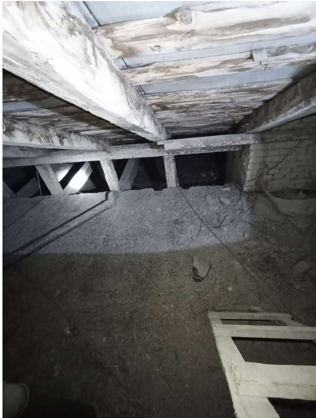
fot.68. widoczny układ konstrukcji dachu, korozja biologiczna, zacieki i zawilgocenia na krokwi i deskowaniu
