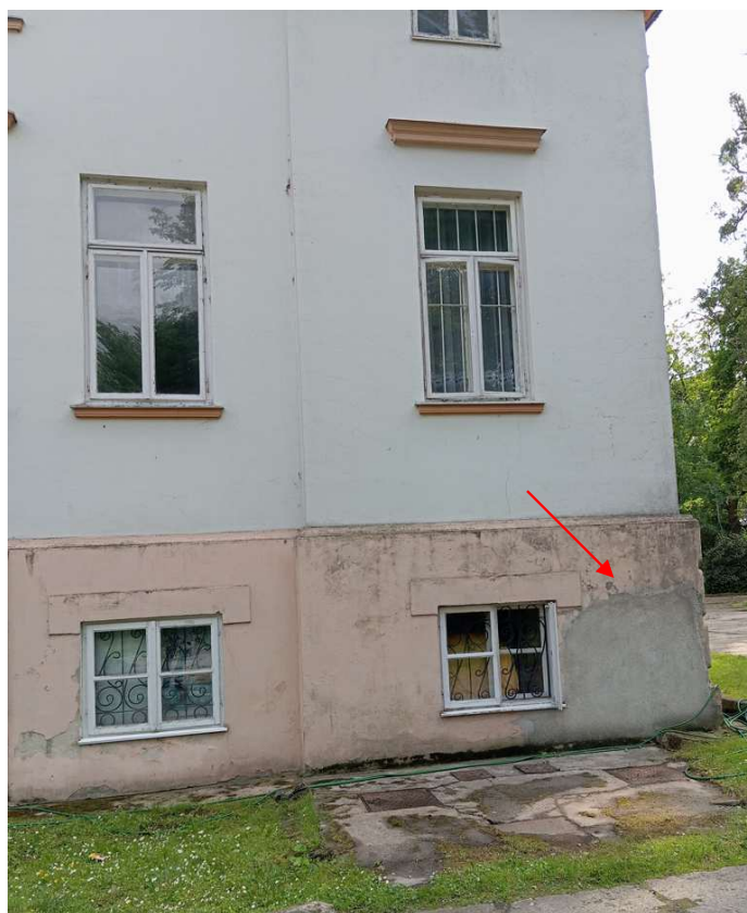
fot.42. widoczne zawilgocenia tynku na elewacji północnej oraz wtórne naprawy tynku
