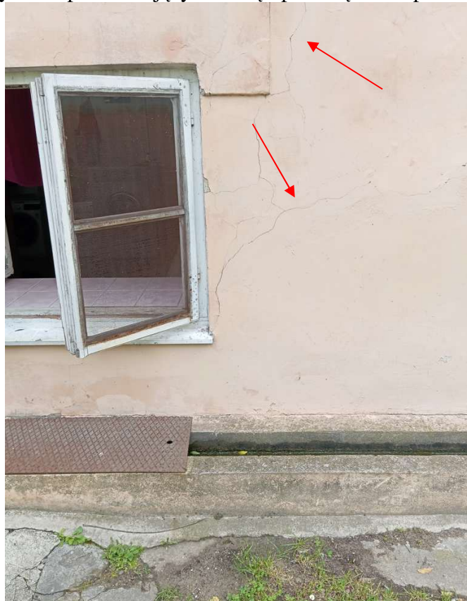
fot.37. widoczne zarysowania tynku w rejonie okna
