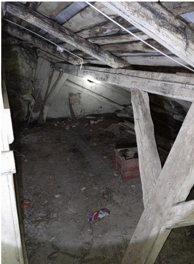
fot.63. widoczny układ konstrukcyjny dachu (krokwie podparte skośną ścianą stolcową z zastrzałami) oraz zły stan techniczny elementów konstrukcyjnych
