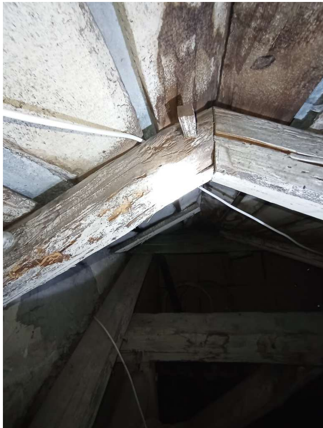
fot.69. widoczne próchnienie drewna i pęknięcia krokwi w rejonie kalenicy
