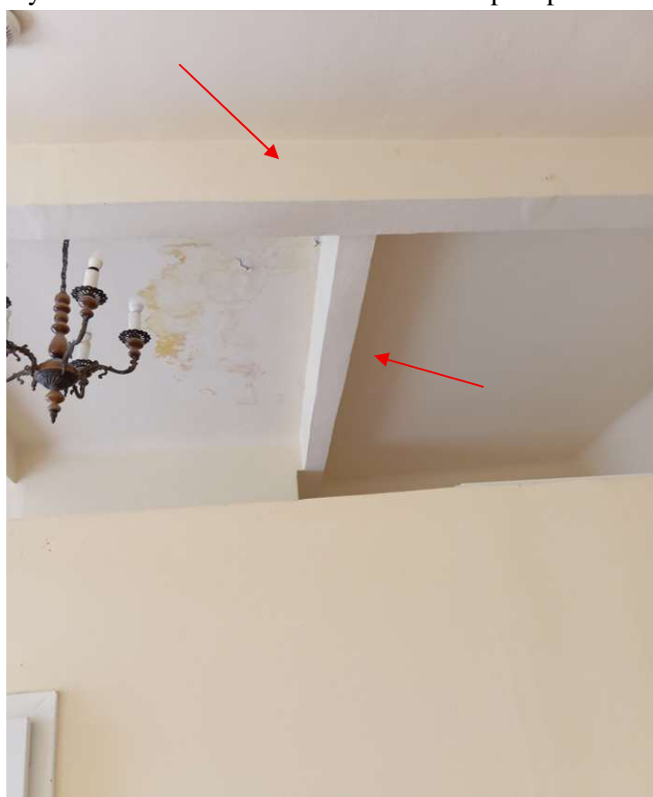
fot.4. widoczne belki stalowe w pomieszczeniu 0.13 na parterze oraz zacieki na stropie
