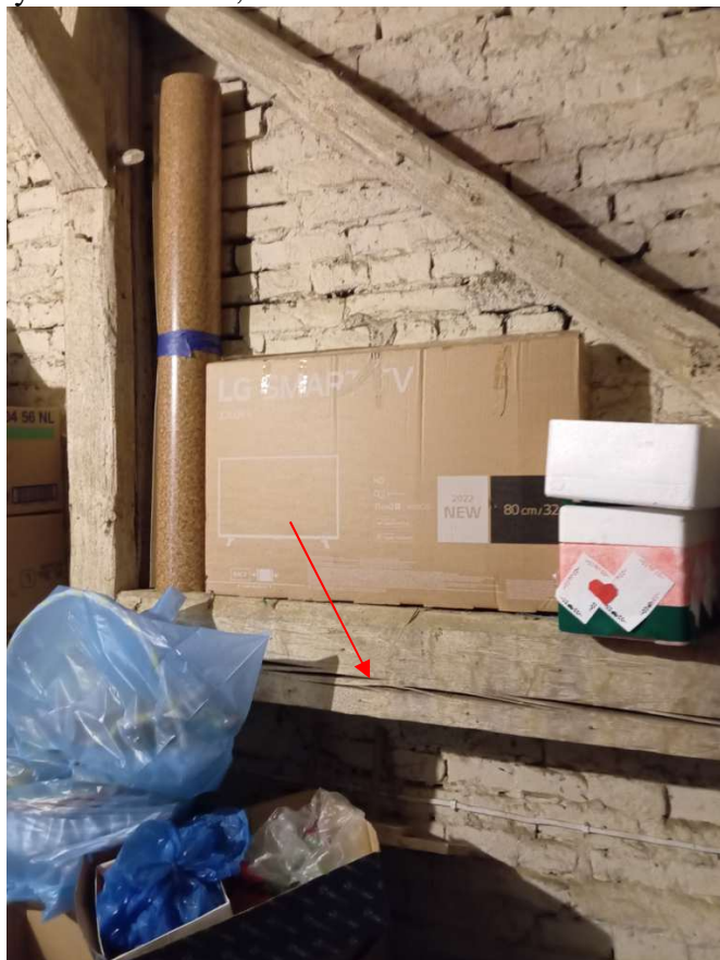
fot.59. widoczne pęknięcie podłużne belki poziomej konstrukcji dachu
