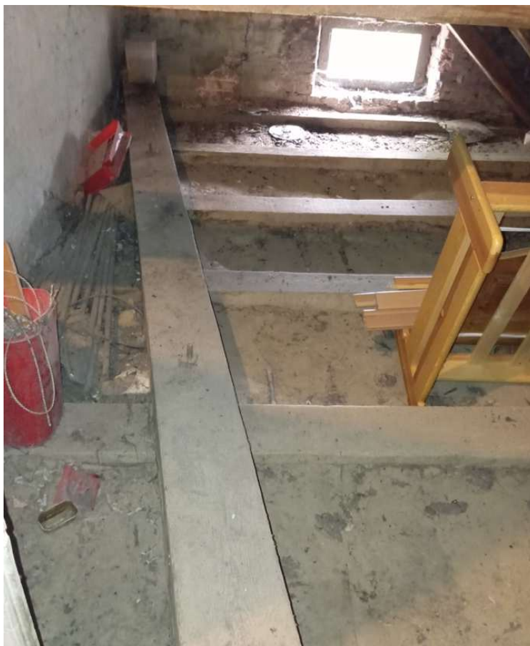
fot.3. odkrywka 03-widoczne belki drewniane stropu z poziomu poddasza
