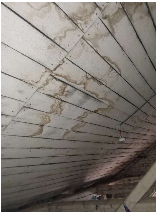
fot.62. widoczne zacieki na deskowaniu poddasza
