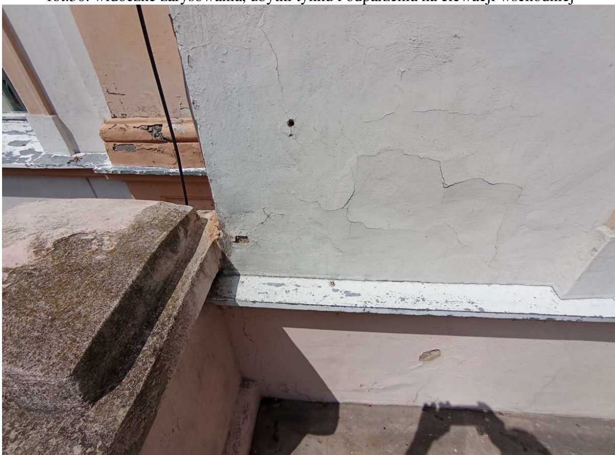
fot.31. widoczne zarysowania tynku na elewacji wschodniej
