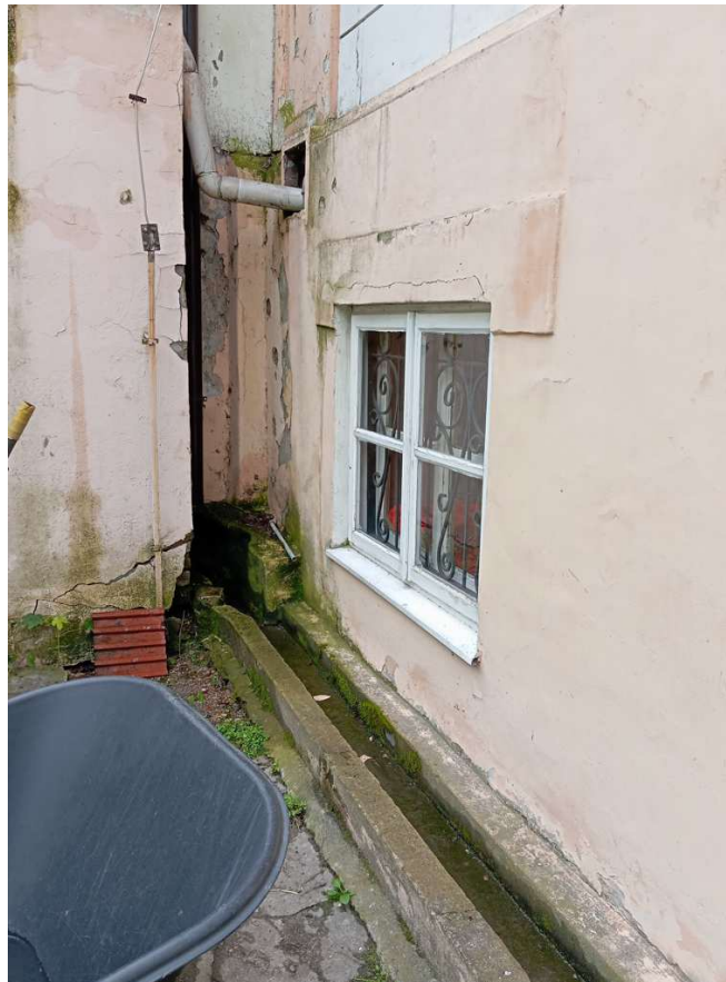
fot.36. widoczne pęknięcie oraz zagrzybienia i zawilgocenia elewacji w rejonie cokołu przy korytku odprowadzającym wodę opadową z rur spustowych
