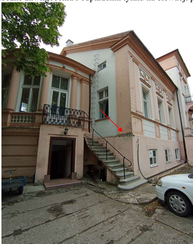
fot.55. widoczne zawilgocenia i zagrzybienia tynku na elewacji południowej
