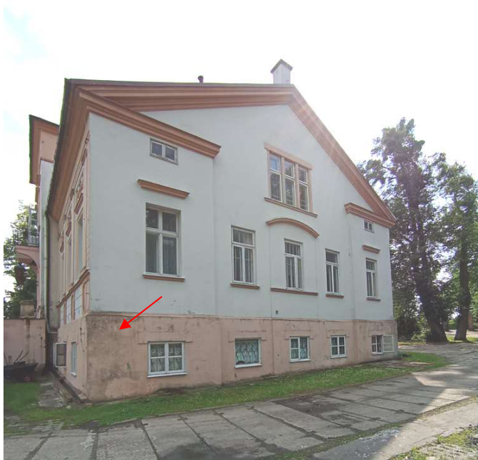
fot.39. widok elewacji północnej i widoczne zagrzybienia tynku w narożniku ściany
