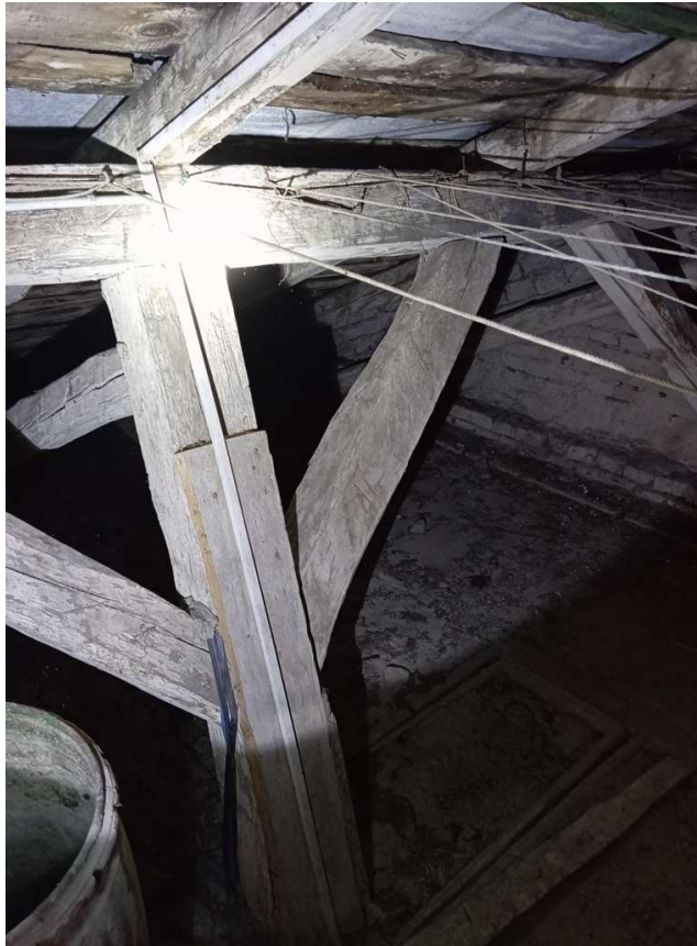
fot.64. widoczny układ konstrukcyjny dachu, spękania i korozja biologiczna elementów drewnianych
