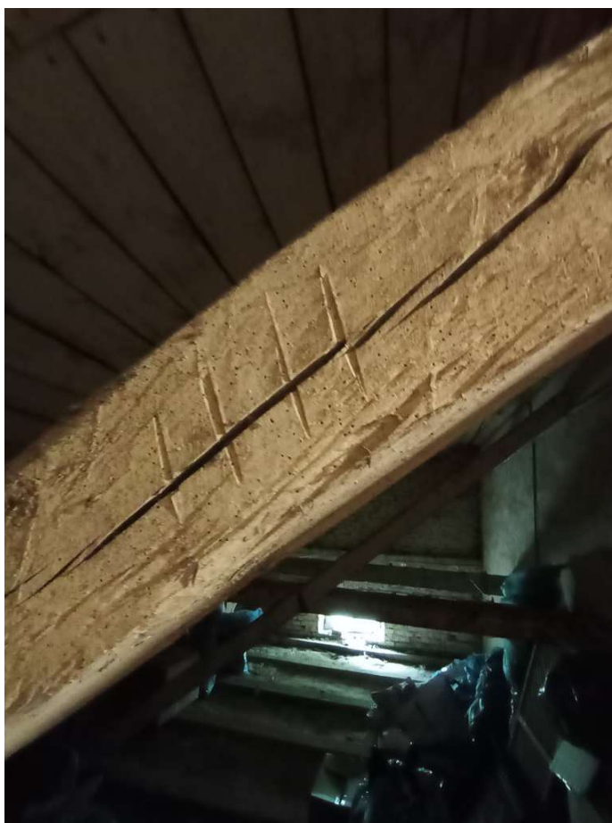
fot.60. widoczne pęknięcie podłużne zastrzału oraz liczne ślady działalności kornika
