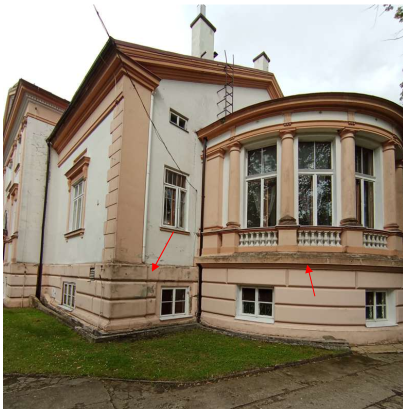
fot.50. widoczne zawilgocenia i zagrzybienie elewacji południowej
