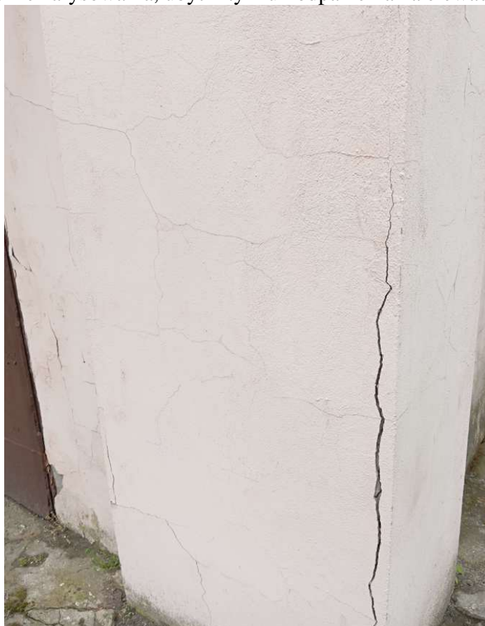
fot.33. widoczne pęknięcie na tynku elewacji wschodniej
