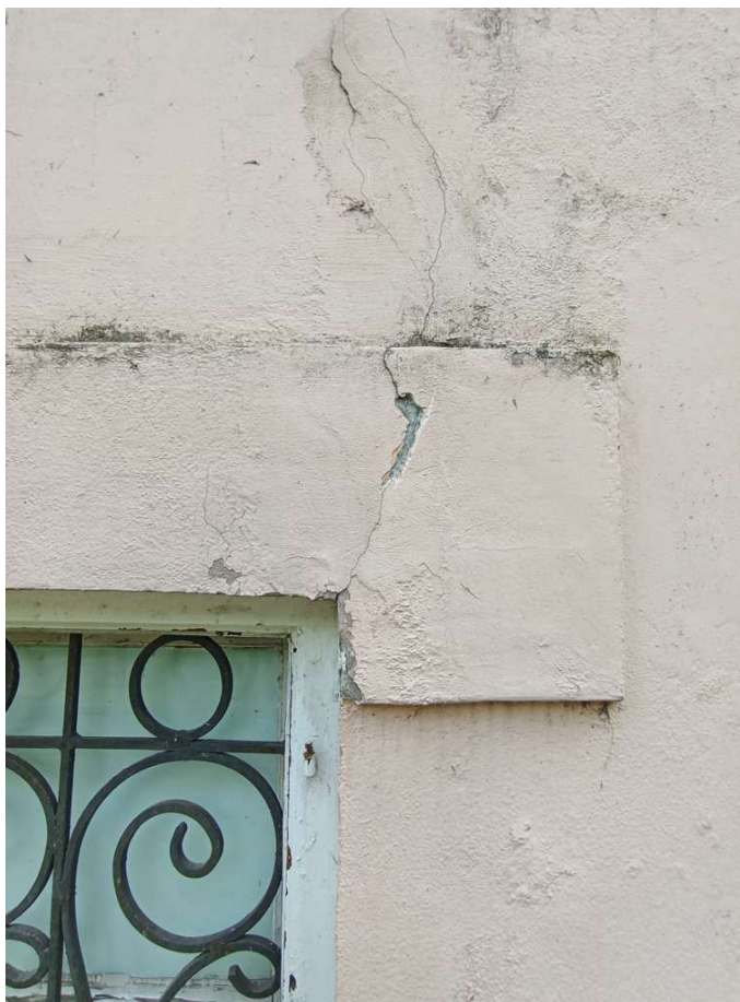
fot.40. widoczne zarysowania tynku w rejonie nadproża okna
